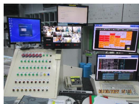
ภาพที่ 2.1-29 Interlock System และ Alarm annunciator
