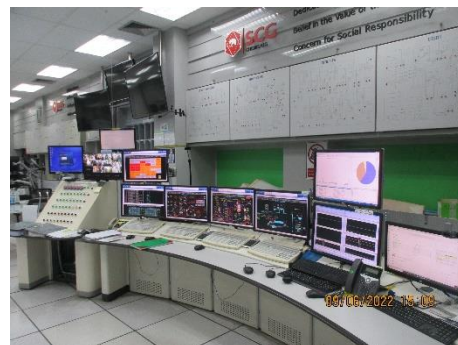
ภาพที่ 2.1-27 Distributed control system (DCS)
