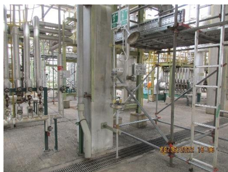
ภาพที่ 2.1-38 ระบบ Safety Showers/Eye Washer บริเวณพื้นที่ลานถัง
