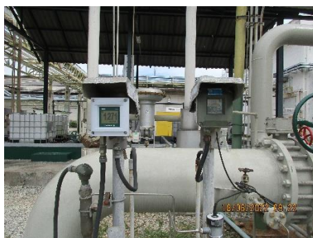
ภาพที่ 2.1-7 เครื่องตรวจวัดคุณภาพน้ำเสียแบบต่อเนื่อง ได้แก่ pH, Temperature, Conduct. (น้ำที่ระบายทิ้งจากระบบหอล่อยื่น)
