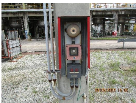
ภาพที่ 2.1-30 ระบบสัญญาณเตือน (Historian Alarm) และระฆังเครื่องไฟฟ้า
