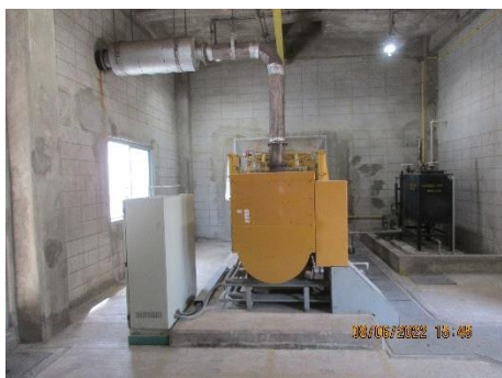
ภาพที่ 2.1-28 ระบบไฟฟ้าสำรอง (Diesel Gen)
